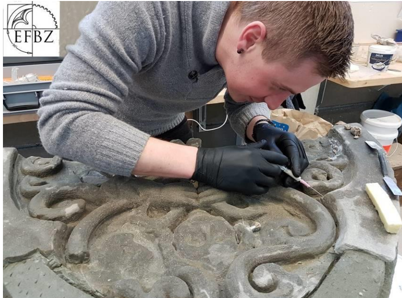
Bild 3: Der Teilnehmer André Schär bei der Rissinjektion an einem Spitzbogentympanon aus Molasse Sandstein.
